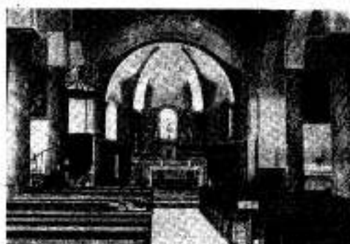
intérieur de l'église après le début des travaux de restauration
