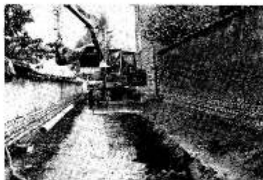
Assainissement : l'axe de la conduite en bord de village.
