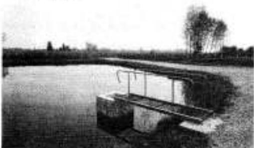
Trois bassins ont été construits. Les eaux usées décaissent dans le premier puis s'écoulent successivement dans les deux derniers avant de rejoindre le ruisseau complètement purifiées. Le temps de séjour des effluents dans les trois bassins sera d'environ 60 jours lorsque le réseau d'assainissement sera terminé. La qualité de l'eau rejetée dans le ruisseau est contrôlée trois fois par an par le SATESE.
