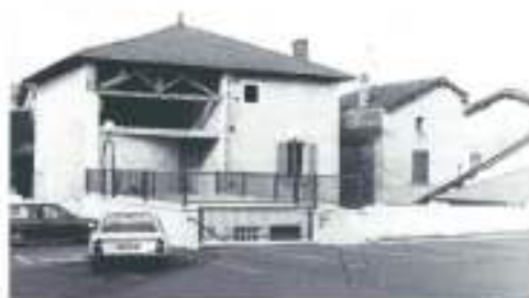
Le parking et les nouvelles toilettes souterraines
