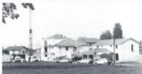
Logements sociaux en construction
