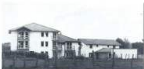
Logements en voie d'achèvement
